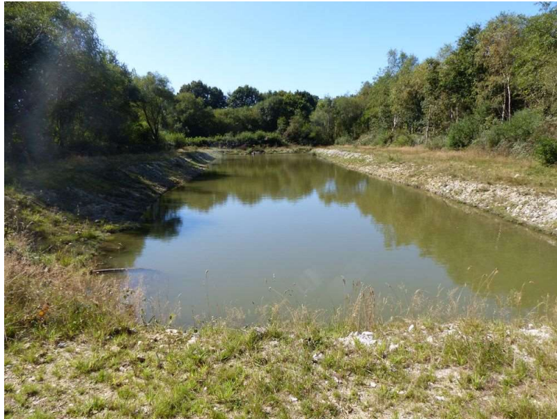
Figure 7 : Bassin de décantation (L. Brunet)
